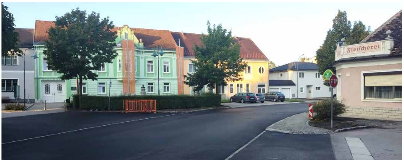
L23 Sanierung: der neu gebaute Kreuzungsbereich der L23 vor dem Rathaus in Neudorf
