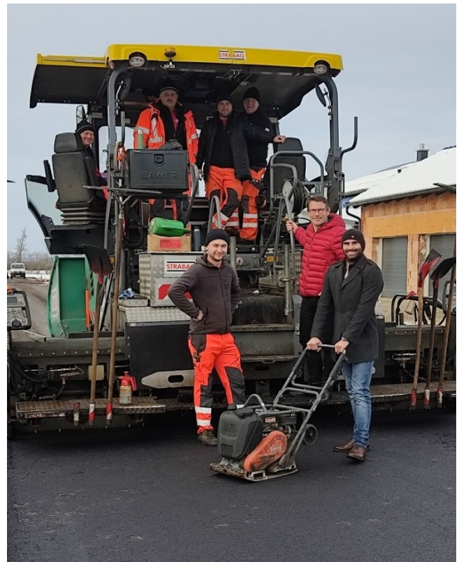
Bgm. Stephan Gartner und VizeBgm. Clemens Manhart bei einer Besichtigung der Straßenbaustelle in der Gartenstraße in Neudorf
